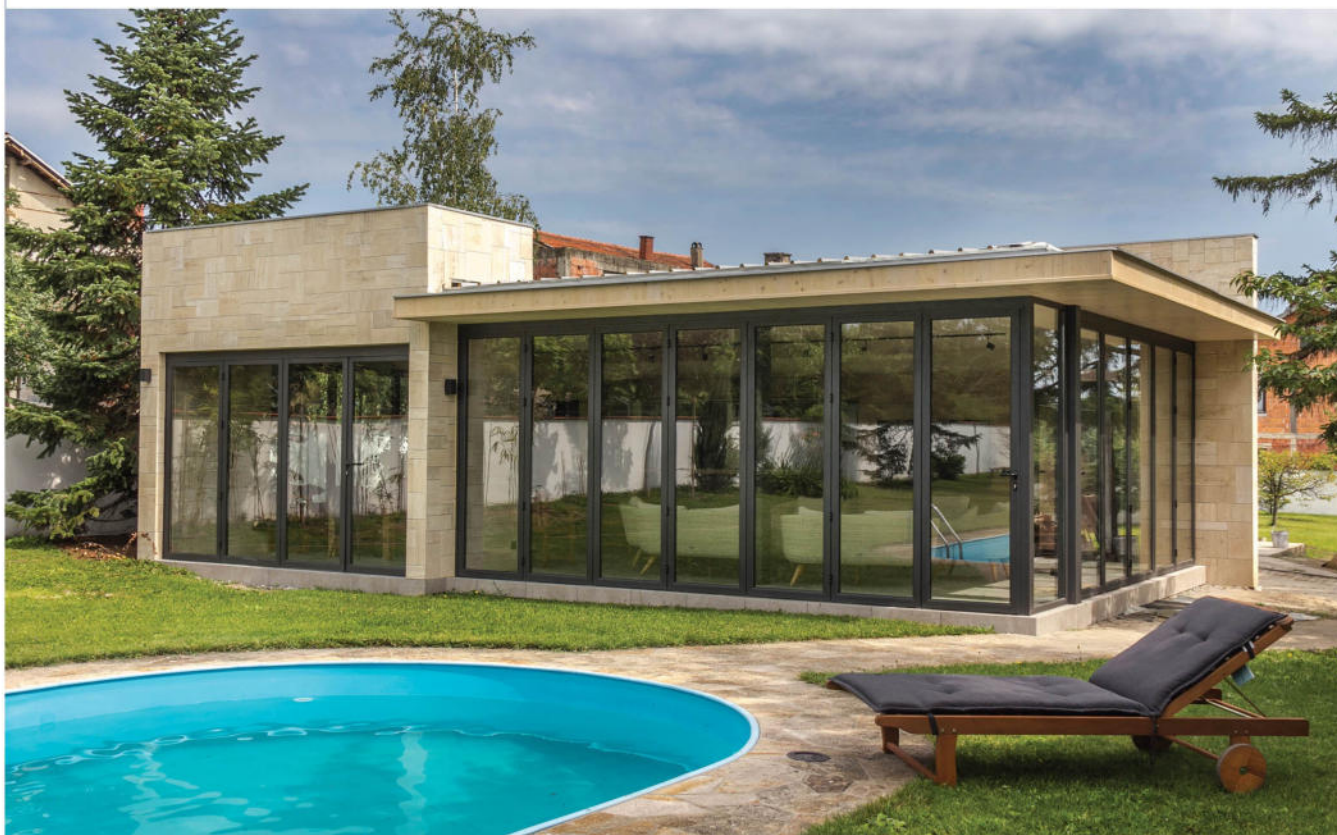
Privatna kuća, Kragujevac
