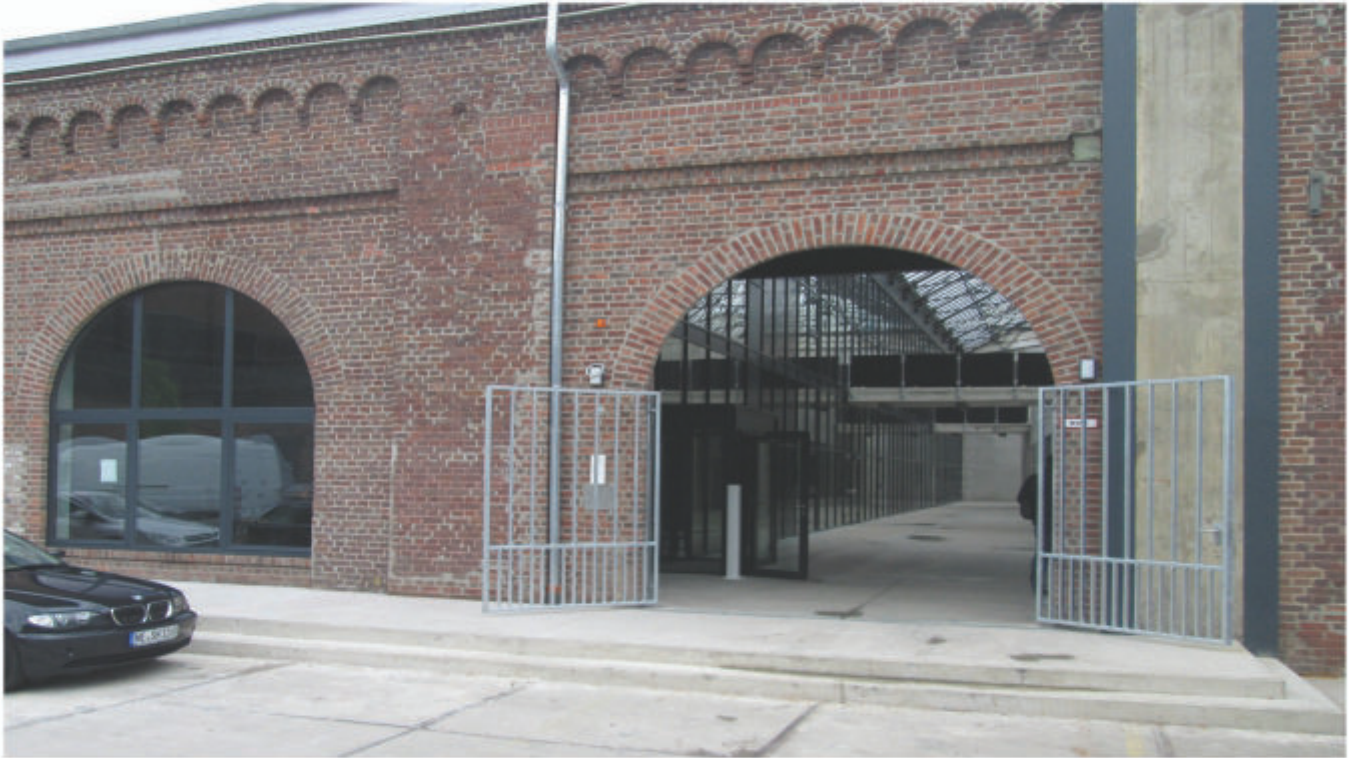
Umbau vom Bahnhof, München, Deutschland Train Station Renovation, Munich, Germany
