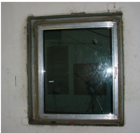
Bild 1 Foto des eingebauten Elementes (erstellt vom ift)
