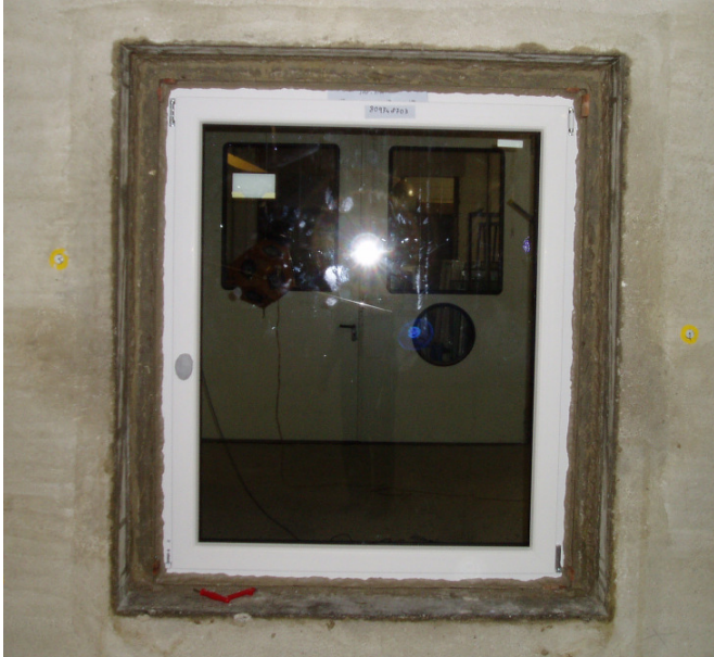
Bild 2 Foto des eingebauten Elementes, erstellt vom ift Schallschutzzentrum
